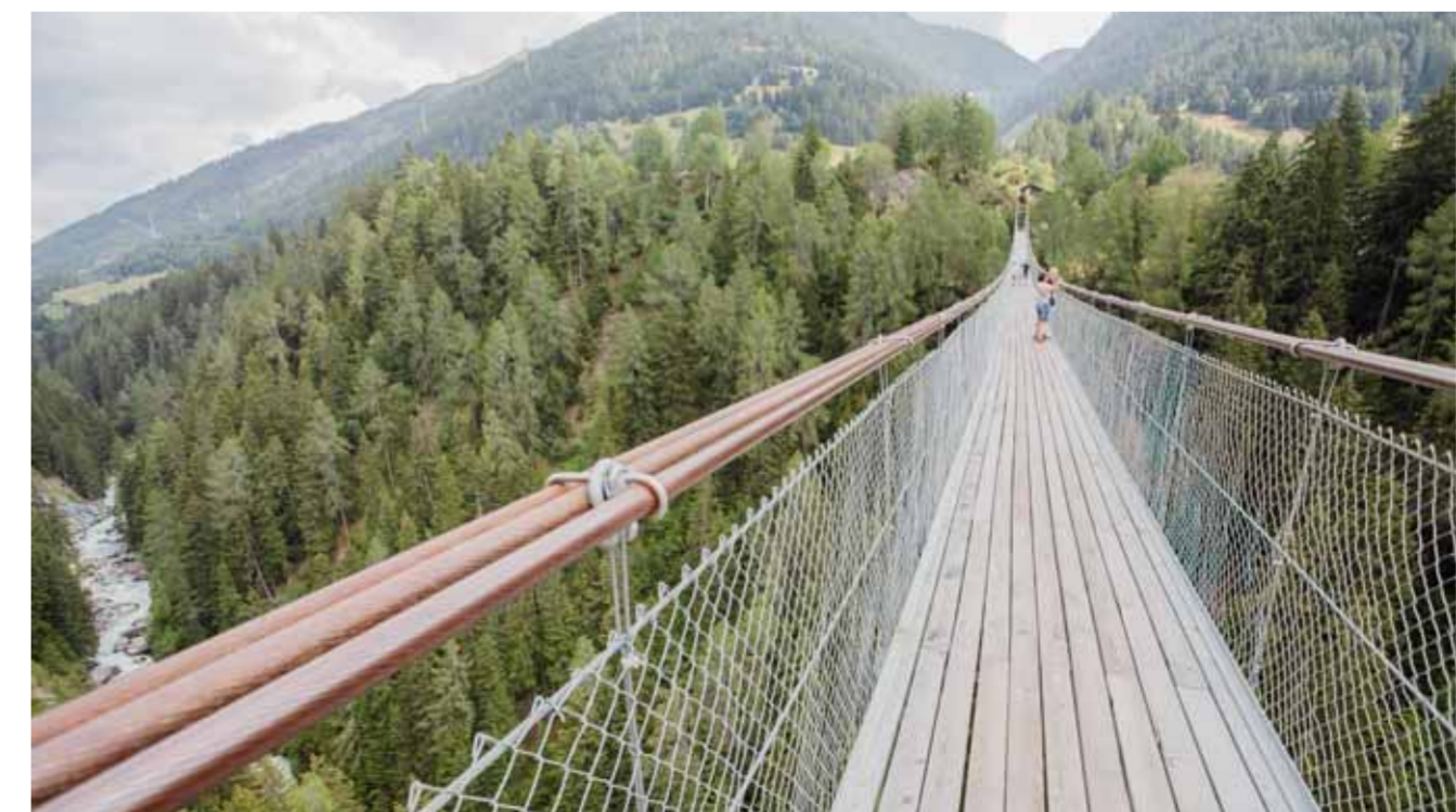
Die Goms Bridge trägt 400 Kilogramm auf einem Quadratmeter – auch wer Höhenangst hat, braucht einen Einsturz nicht zu fürchten.
