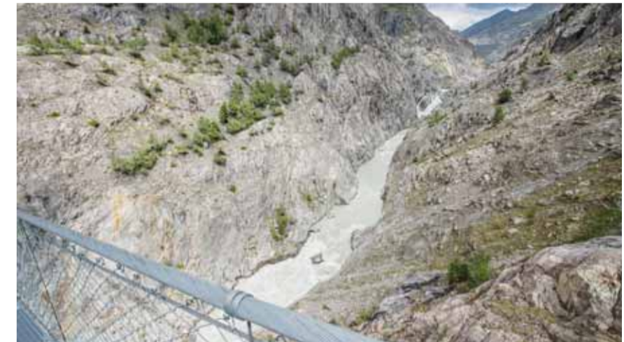
Massaschlucht mit Hängebrücke: Sie verbindet die Belalp mit der Riederalp.
